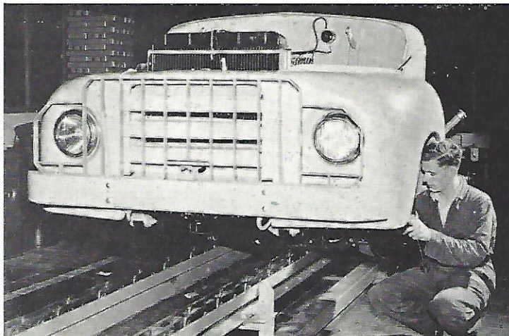
De voorkant van een nieuwe „Pick-up”, bestemd voor de N.V. De Bataafsche Petroleum Maatschappij, wordt bevestigd.
