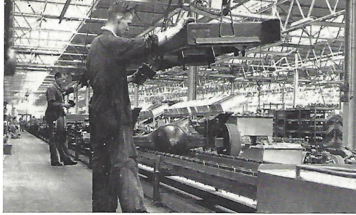
Een gedeelte van de chassis-montageband.
